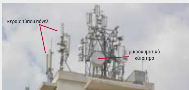
Σχήμα 3: Κεραιές από τις οποίες αποτελείται ένας χαρακτηριστικός σταθμός βάσης
